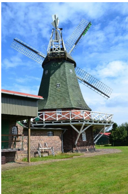
Holländerwindmühle mit Hochgalerie in Muslum (Baudenkmal)
